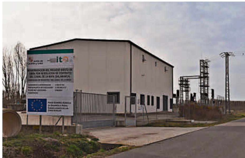
Edificio donde está el sistema de control de riego de la Comunidad. EÑE
