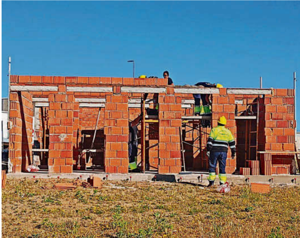
La obra de las casetas de aperos para los nuevos huertos de Castellanos de Moriscos. FOTOS: EÑE
