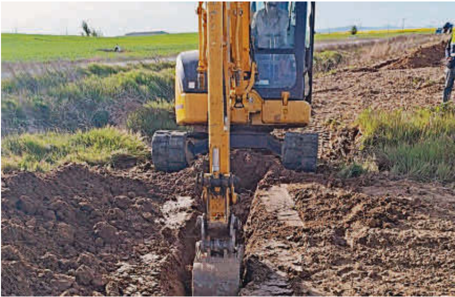
Obras dentro de la Comunidad de Regantes Canal de La Armuña.
