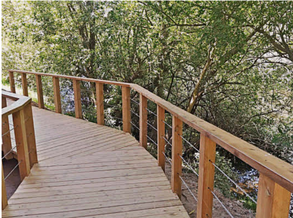
Nueva pasarela de madera en el entorno del camino de las Aceñas, próxima al puente medieval. FOTOS:ÉNE
