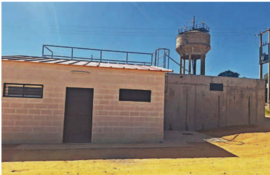
Nuevo depósito construido en Cuatro Calzadas, término municipal de Martinamor. EÑE
